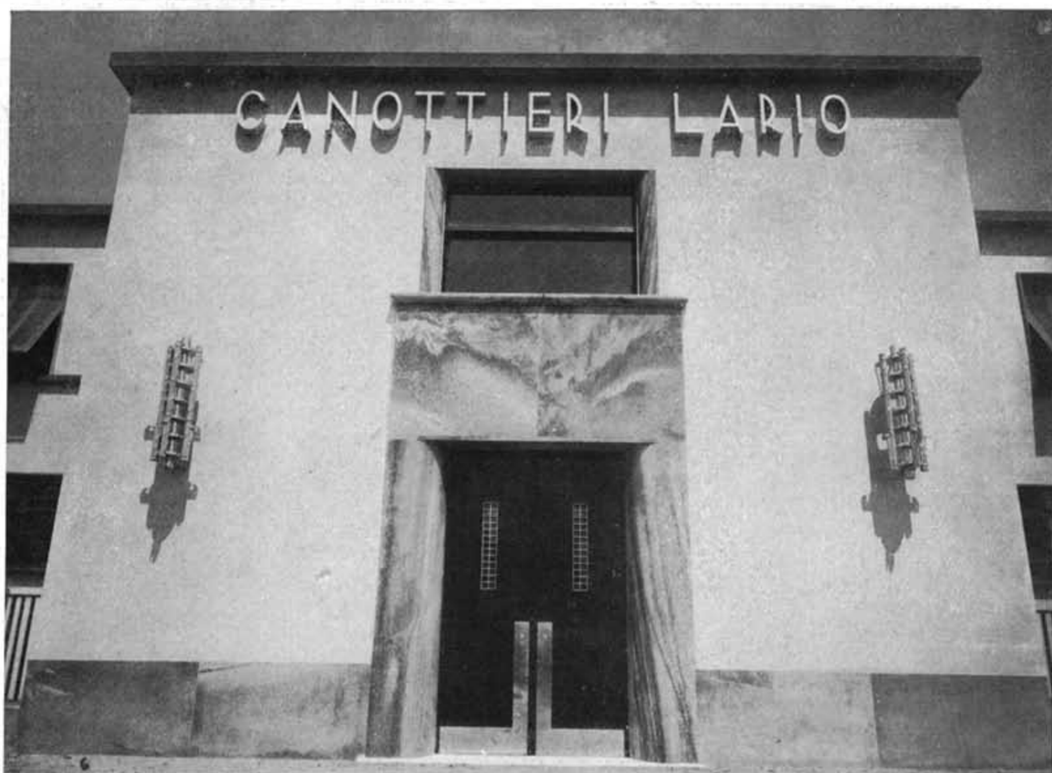
PARTICOLARE DELLA FACCIATA PRINCIPALE
