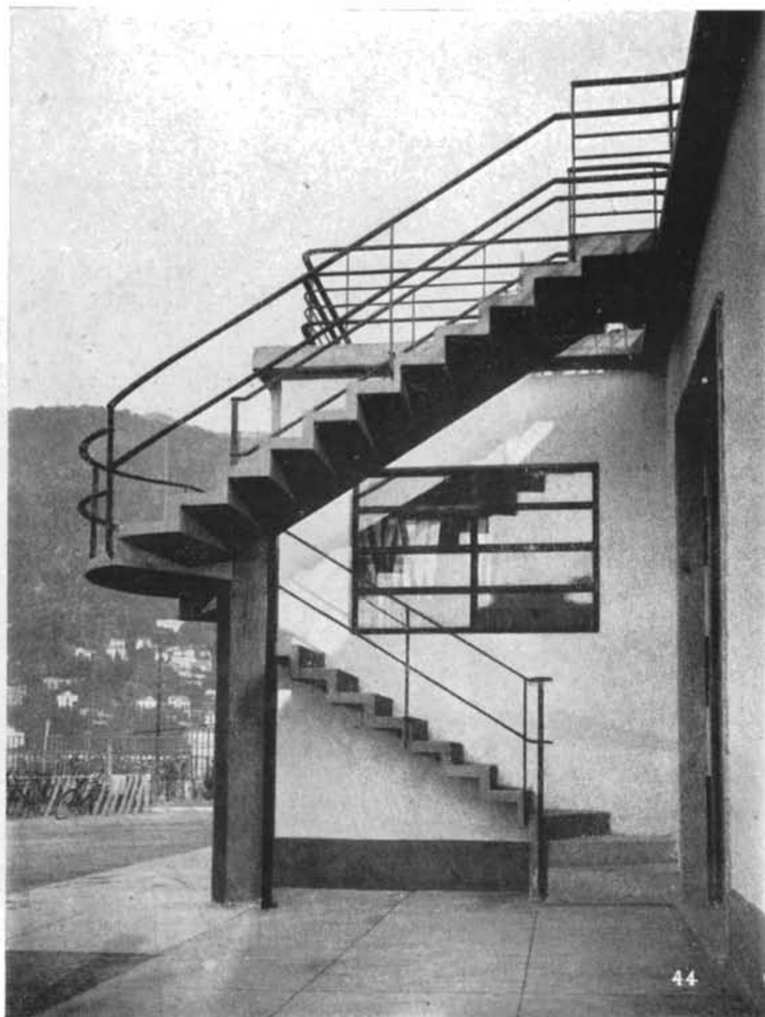
In alto: Veduta panoramica della grande vetrata della Hall. In basso a sinistra: Trampolino a tre piani in cemento armato | Pilastrini e nervature portanti verniciati in cromalite rossa | Gli spessori delle solette in alluminio parapetti con piantane in rosso e tubi orizzontali in anticorodal. In basso a destra: Cemento naturale e parapetto in rosso.
