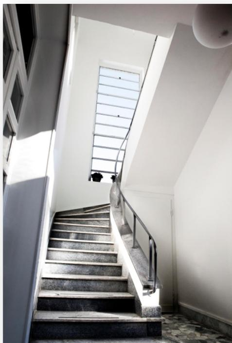
Di particolare rilievo è la scala ellissoidale che sale dal pianterreno al piano superiore con gradini in marmo di Musso, squadernati lungo un'ardita pendenza e protetti da un essenziale corrimano in *anticorodal*, una lega di alluminio, rame, manganese e magnesio resistenti alla corrosione. I locali interni sono stati studiati per la massima funzionalità.
